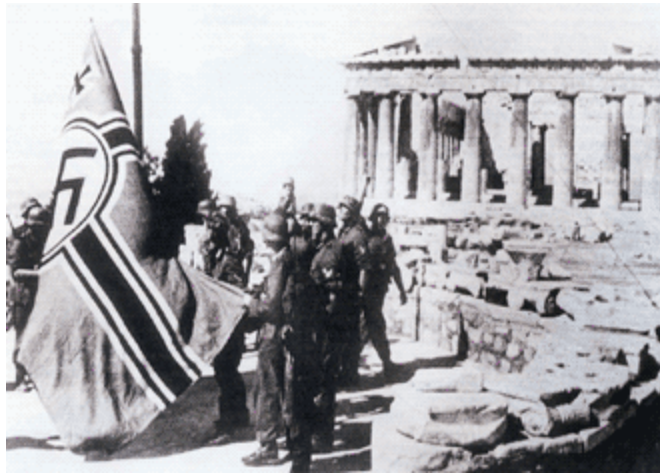
27 Απριλίου 1941 (ύψωση της σημαίας του Γ΄ Ράιχ στην Ακρόπολη) (πηγή: διαδίκτυο)
